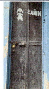
FOTO 2: Sustitucion de puerta en Servicio Sanitario
