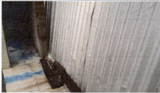
FOTO 1: Sustitución de lámina, por lámina troquelada aluzinc calibre 26 Y Sustitución de estructura de soporte de madera, por metal
