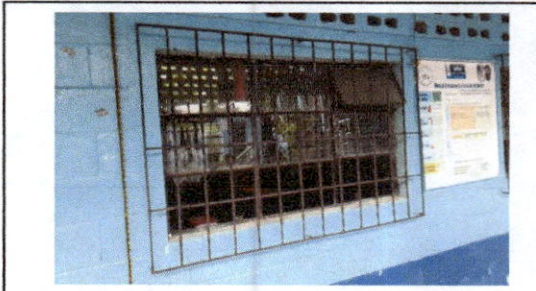
FOTO 8: Mantenimiento a balcones de metal
