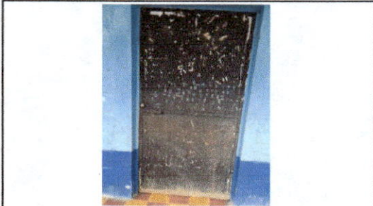
FOTO 7: sustitucion de puerta de metal (incluye chapa)
