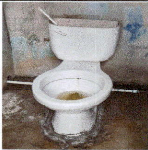
FOTO 3: sustitucion de inodoro (completo)
