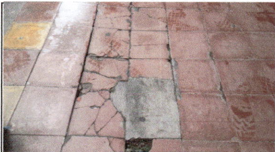
FOTO 5: Sustitución de piso de granito
