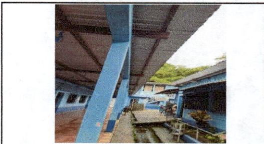
FOTO 9: Sustitución de canal de metal
